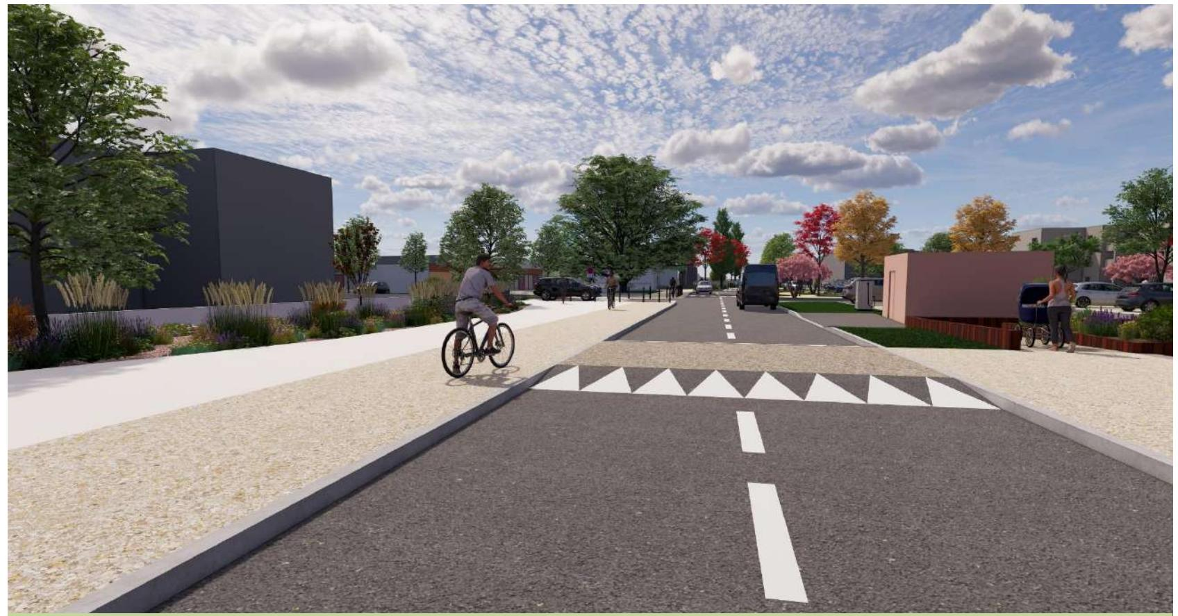
Ralentisseur trapézoïdal avec résine gravillonnée pour sécuriser la traversée devant l'école **2**
