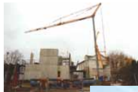
Un nouveau bâtiment est en train de sortir de terre, relié par une passerelle à la mairie historique.
