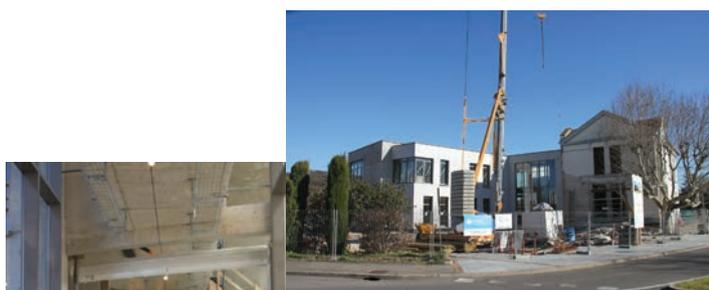
*L'extension de la mairie et la passerelle la reliant au bâtiment historique (ci-contre) prennent forme petit à petit avec la pose des fenêtres et des menuiseries extérieures (mise hors d'eau et hors d'air).*
