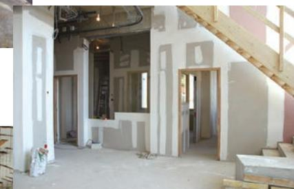
*Dans les trois mois à venir, le chantier se poursuivra avec les travaux de second-œuvre : installation électrique, chauffage, ventilation, cloisonnement intérieur, revêtement de sols.*
